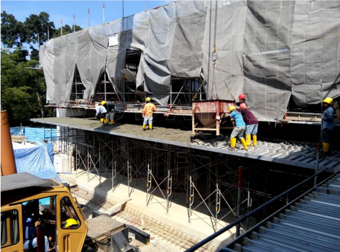
Pouring on site
